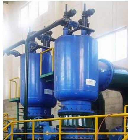
Фильтры YamiT серии **MEGA** производятся в корпусах пяти разных диаметров (корпус может иметь различную высоту в пределах одного диаметра). Такой подход позволяет размещать и использовать в корпусах фильтров **MEGA** весь ассортимент фильтрующих сеток фирмы:
